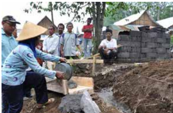
Pembangunan Kembali Rumah Warga
