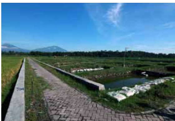
Kolam dan Akses Jalan
