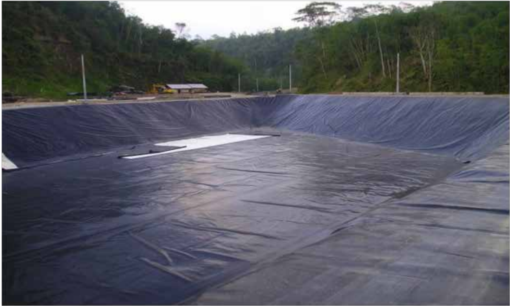
Gambar Lapisan Kedap Air Pada Lapisan Dasar TPA
