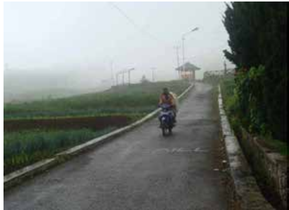
Jalan Poros Desa & Saluran Drainase
