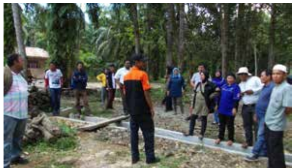
Pembangunan Saluran Air
