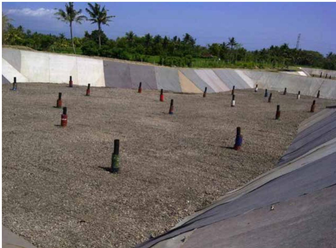
Gambar Sel Landfill dan Pipa Pengumpul Gas
