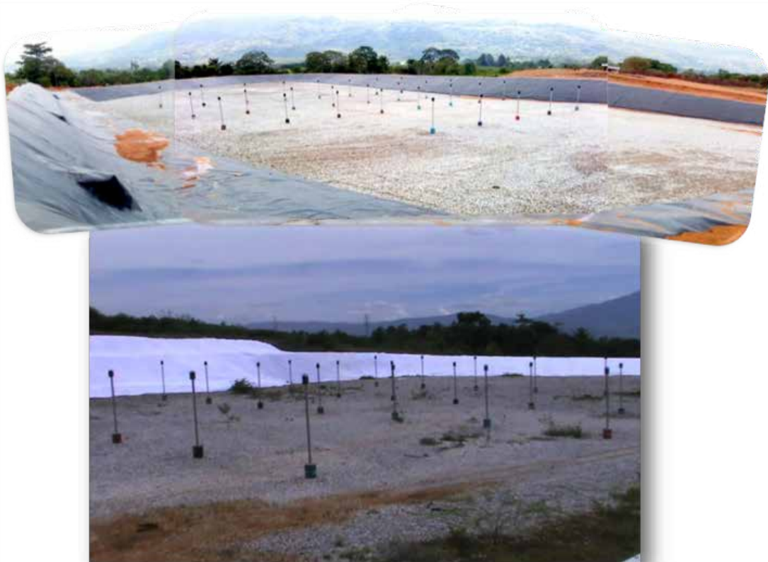
Gambar Konstruksi Standar Sanitary Landfill
