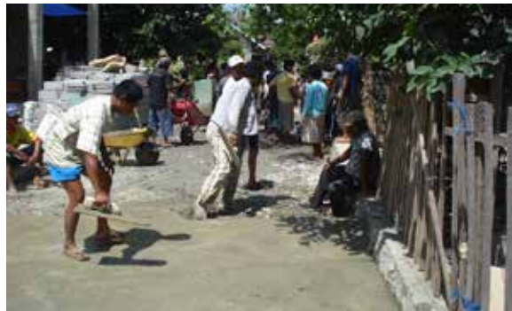
Perbaikan Jalan Akses
