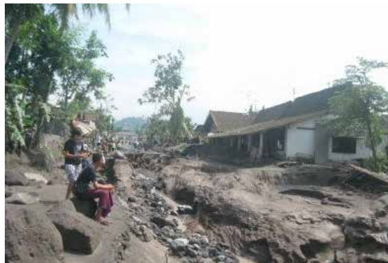
Perbaikan Saluran Drainase Pasca Bencana
