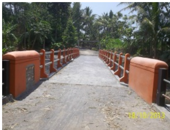
Perbaikan Jembatan Akses
