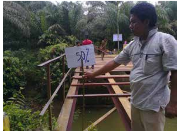
Pembangunan Jembatan Patisipatif
