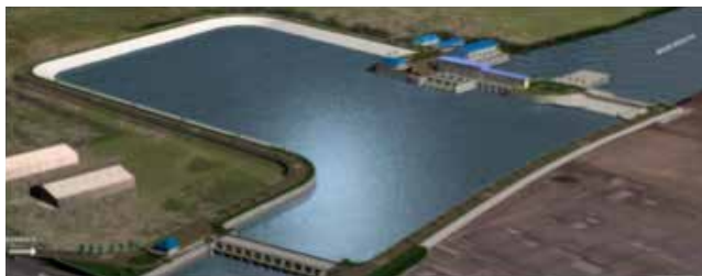
Kolam Penampung Air
