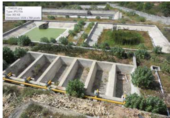
IPLT yang over desain & kekurangan asupan lumpur tinja
