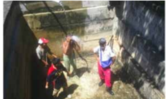
Pembangunan Bak Tampung Air Bersih
