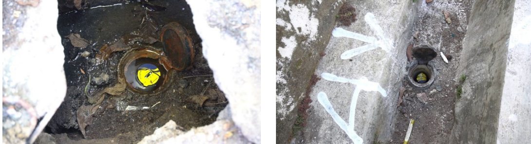
Gambar 18 Ilustrasi dan Diagram Pemasangan Sensor Leak Correlator Primayer Enigma
