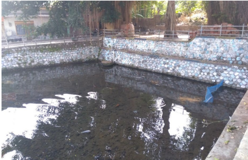
Gambar 13. Foto Kolam Penampungan Mataair Kalibenoyo
